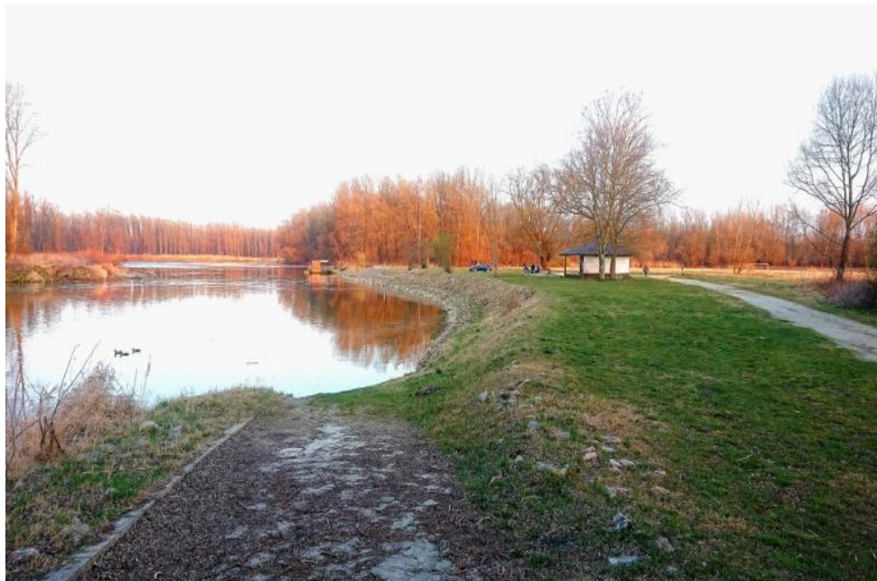
Slika 19. Zaton i rampa na rijeci Muri kod Podturna
