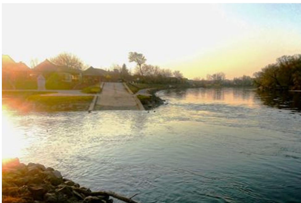
Slika 18. Lučica i rampa na Muri u Murskom Središću
