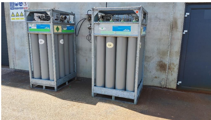
Slika 33 Baterije plina - Corgona
