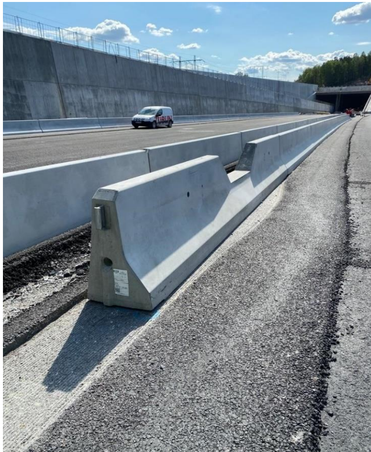
Slika 16. Betonski zid na autocesti
