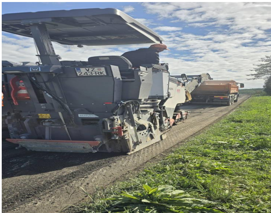
Slika 23. Glodanje asfalta frezom
