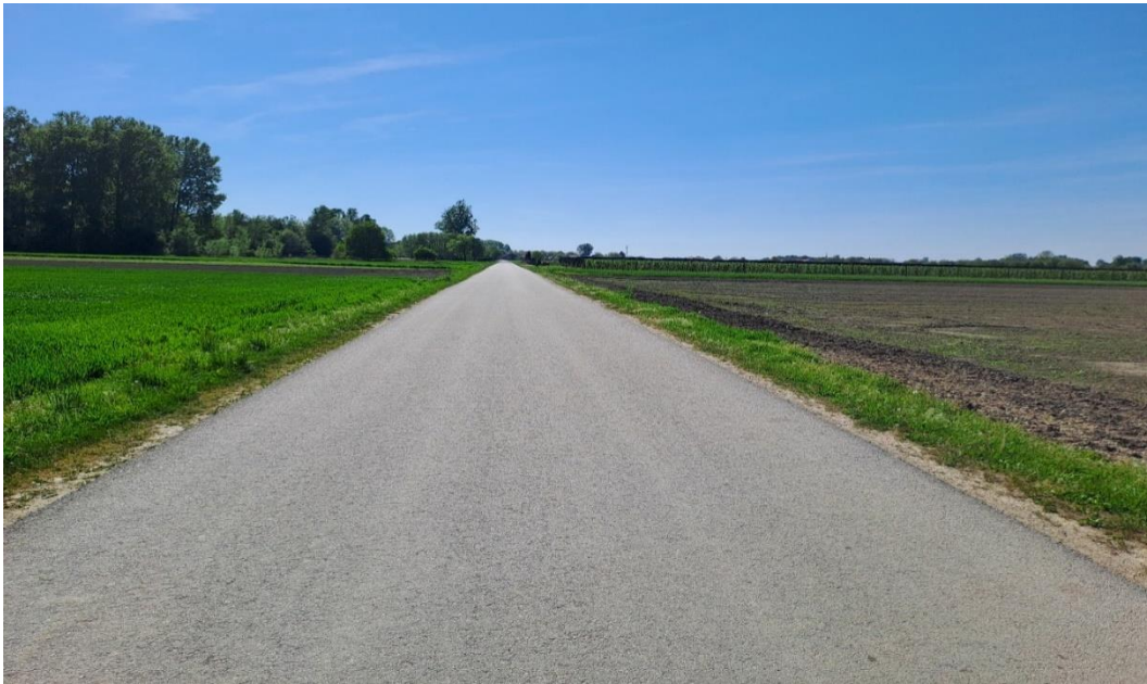
Slika 13. Lokalna cesta LC20086 Draškovec- Čukovec
