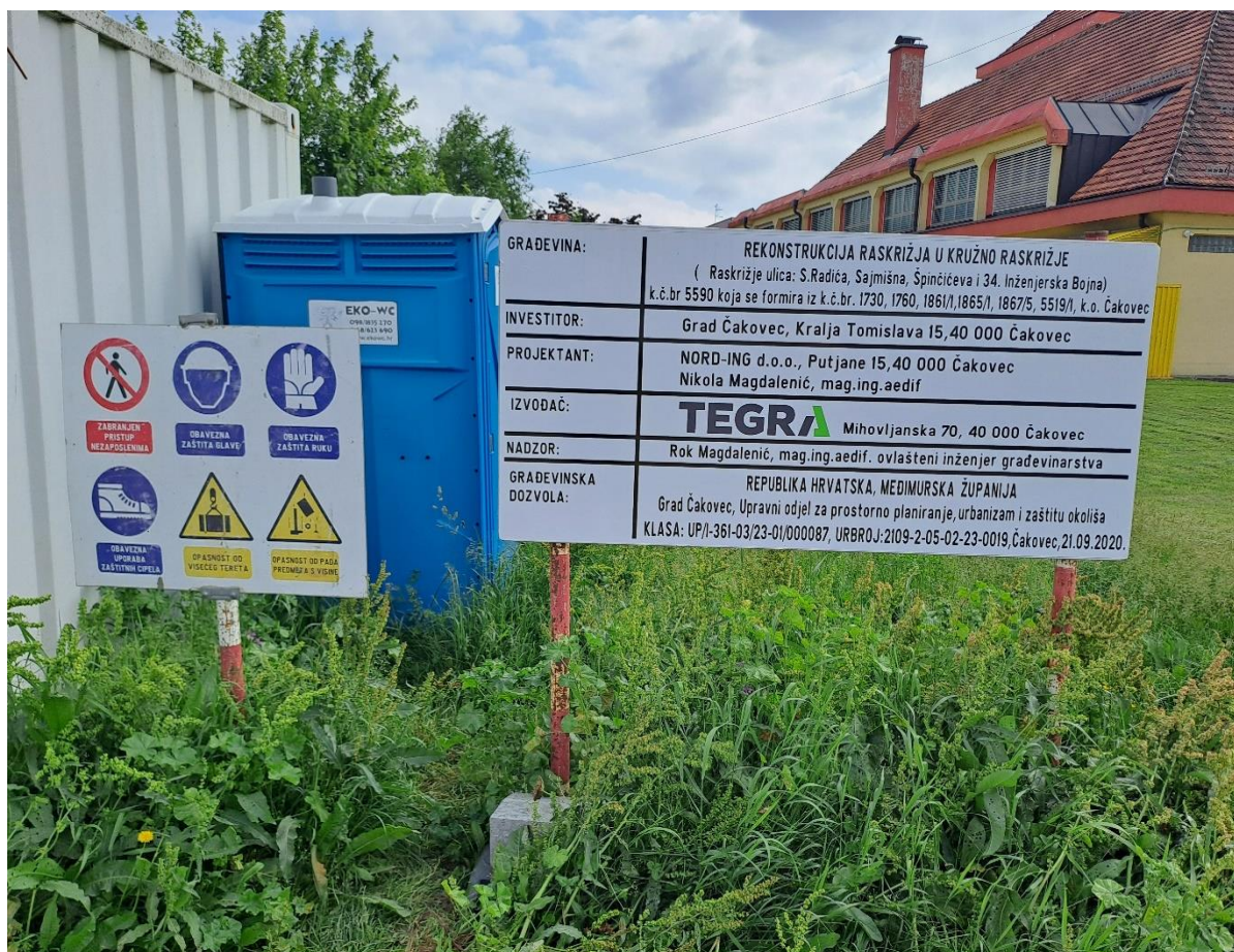
Slika 20. Tabla gradilišta sa tablom zaštite na radu
