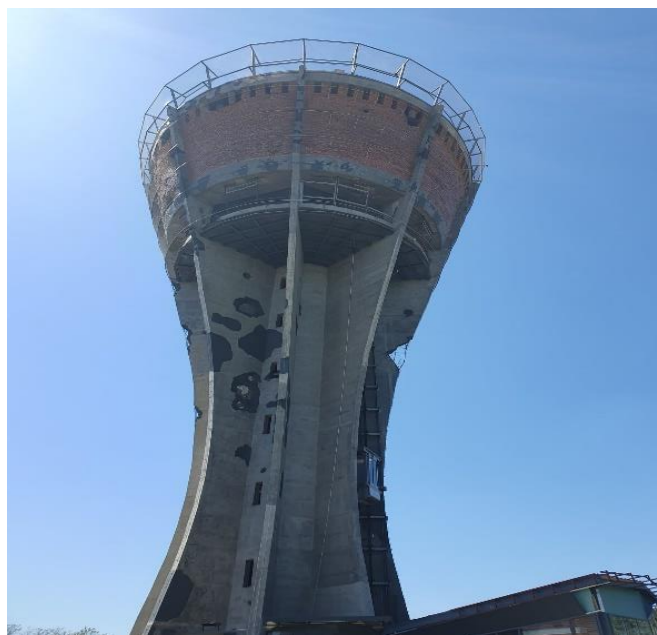
Slika 18. Vukovarski vodotoranj nakon obnove
