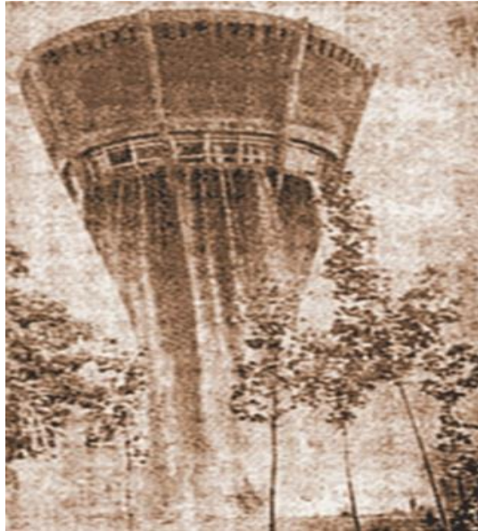
Slika 10. Propuštanje vode iz vodotornja dvije godine nakon otvaranja, 1970.
