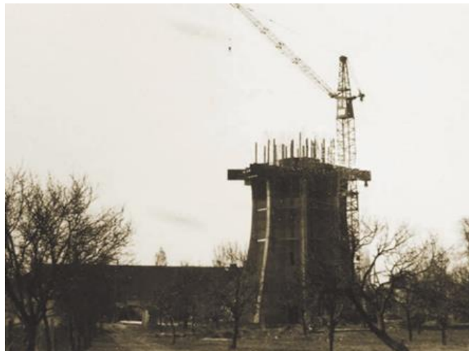
Slika 11. Početak izgradnje novog vodotoranja
