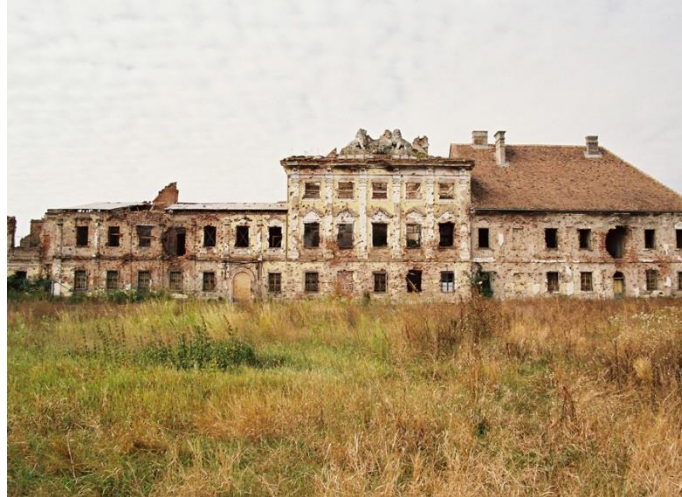
Slika 32. Dvorac Eltz srušen u Domovinskom ratu
