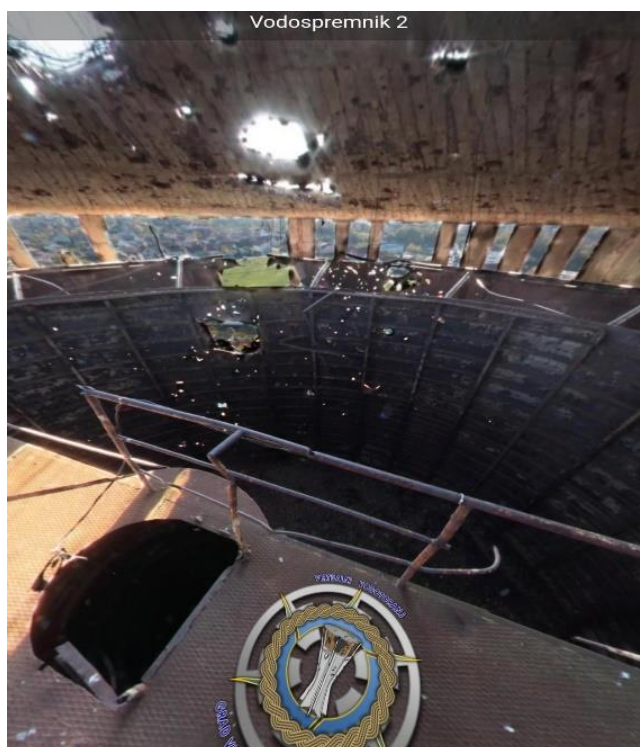
Slika 15. Pogled iz vodospremnika
