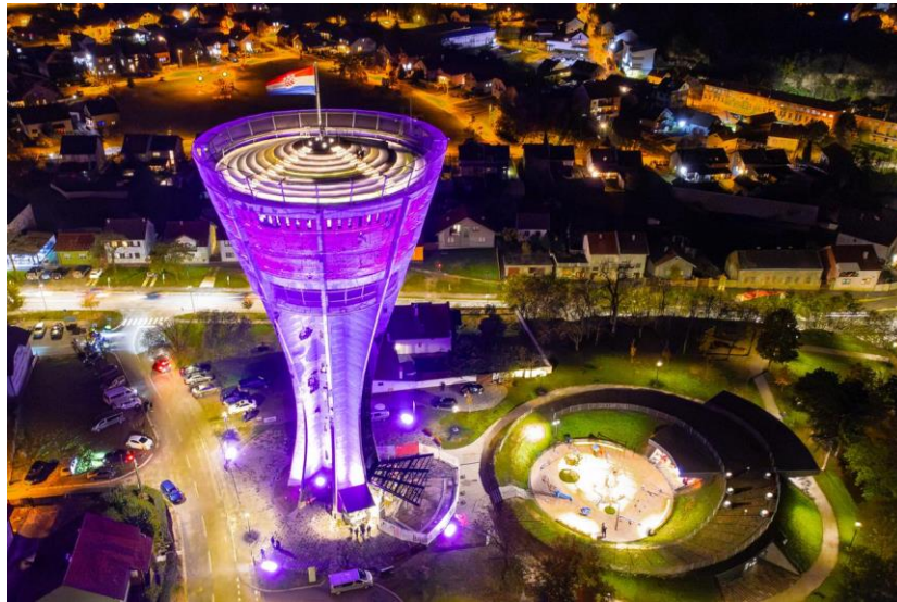
Slika 23. Prikaz obnovljenog Vodotoranja iz zraka
