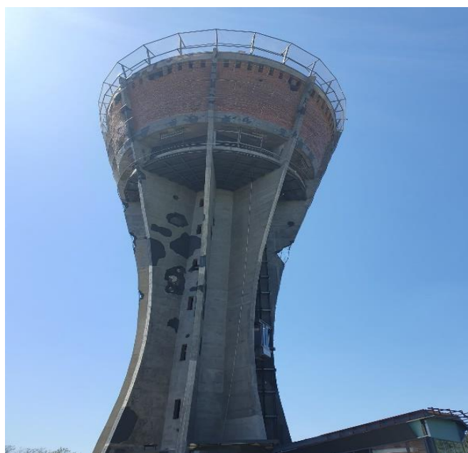
Slika 18. Vukovarski vodotoranj nakon obnove
