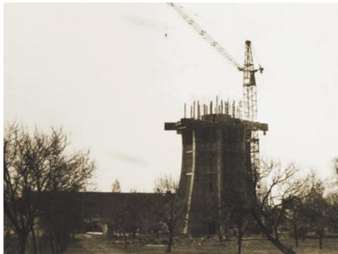
Slika 11. Početak izgradnje novog vodotoranja
