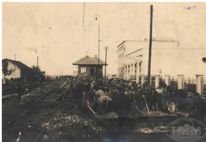
Slika 3. Ugradnja skretnice u kolodvoru Koprivnica
