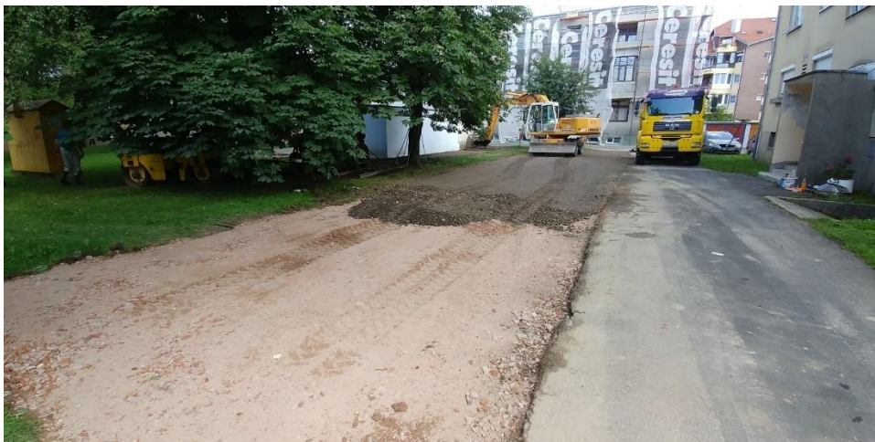
Slika 15. Ugradnja recikliranog agregata-primjer dobre prakse [5]
