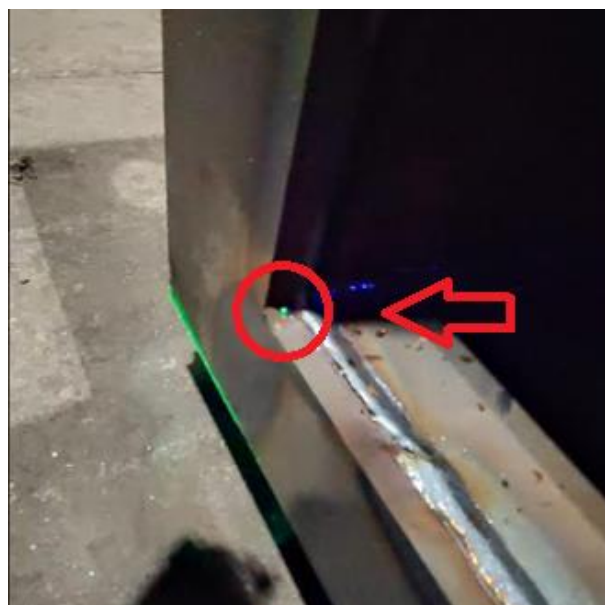
Slika 43. Drugo propuštanje kotla
