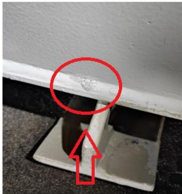
Slika 57. Drugo propuštanje kotla
