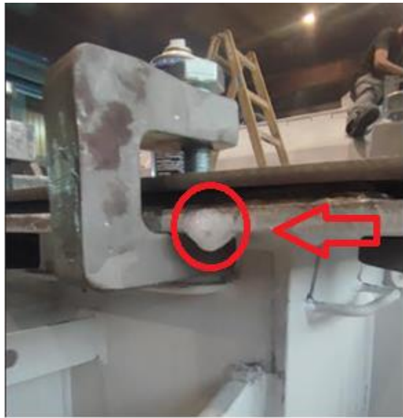
Slika 31. Propuštanje kotla tijekom tlačnog ispitivanja
