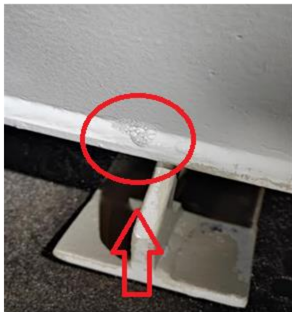
Slika 57. Drugo propuštanje kotla
