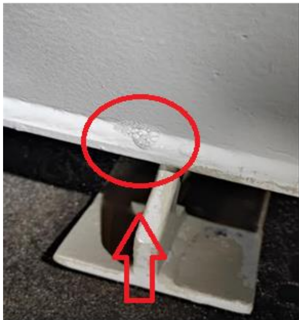
Slika 57. Drugo propuštanje kotla
