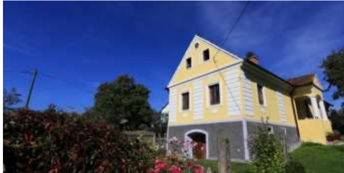
Slika 4. Naselje starih kuća u Črečanu
