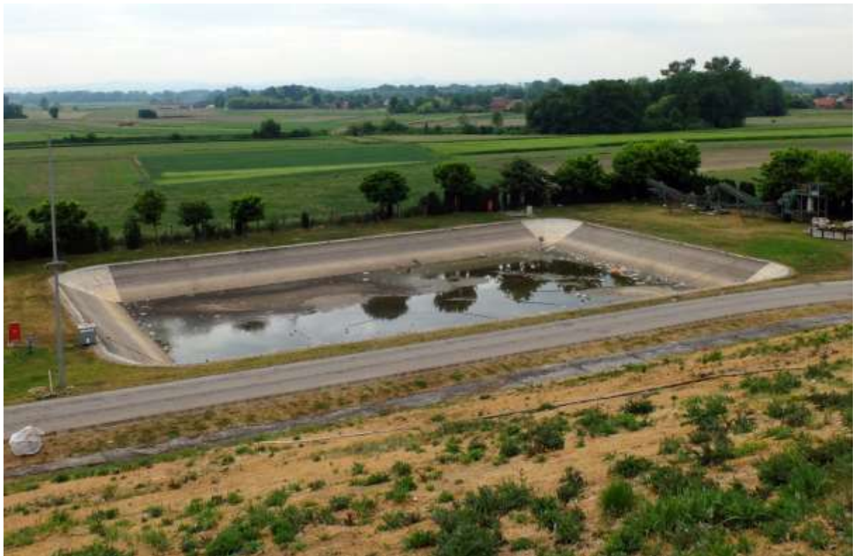
Slika 3. Prikaz bazena za procjedne vode na odlagalištu otpada Totovec
