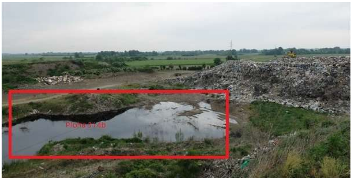
Slika 4. Prikaz nesaniranog dijela odlagališta otpada Totovec, plohe 3 i 4b
